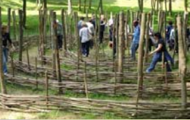
Château de Pierrefonds - « réalisation du chantier d'insertion avec la plasticienne Marie Goussé »
